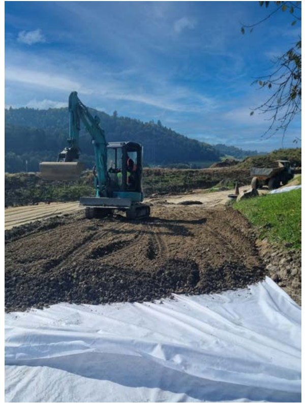
Abb. 5.6: Bau der neuen Transportpiste von der Einfahrt Nord (Blickrichtung SW von der Hofstrasse her)
