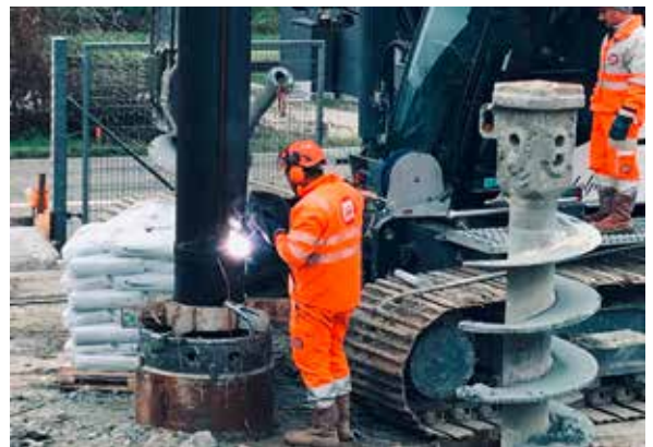
Abb. 5.5 Verschweissen von Filterrohren während dem Einbau in den FBM12, rechts eine verwendete Bohrschnecke.
