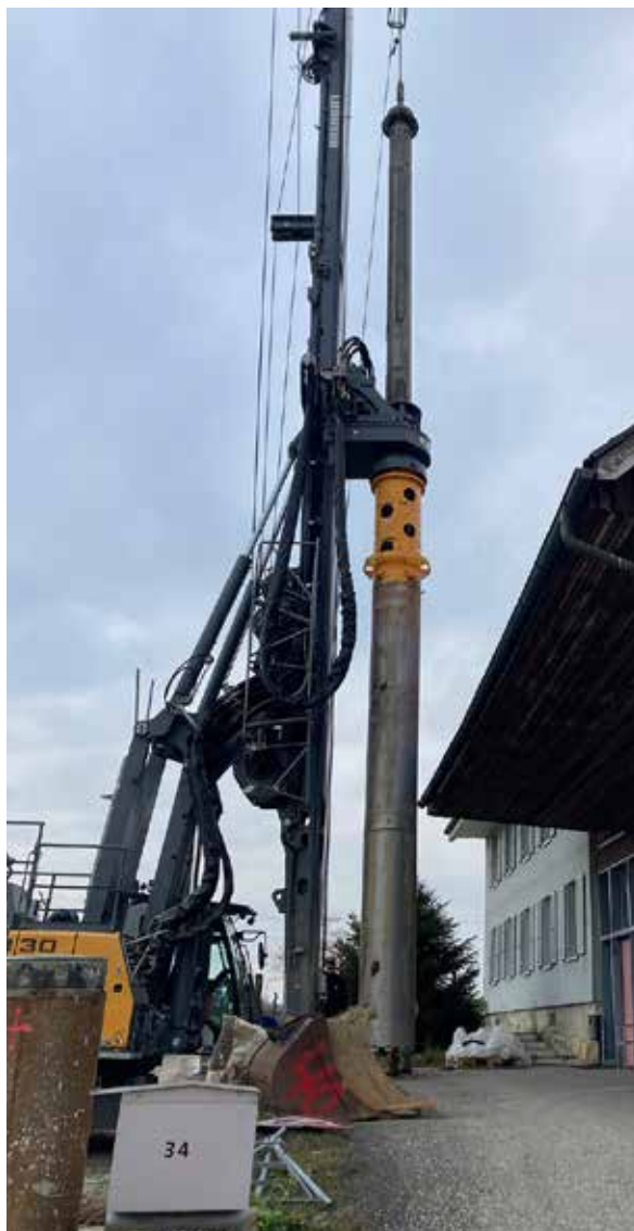
Abb. 5.3: Erstellung der Bohrung FBM14 vor der Geschäftsstelle der SMDK
