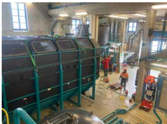
Abb. 3.3: Abbruch Tauchtropfkörper 1
