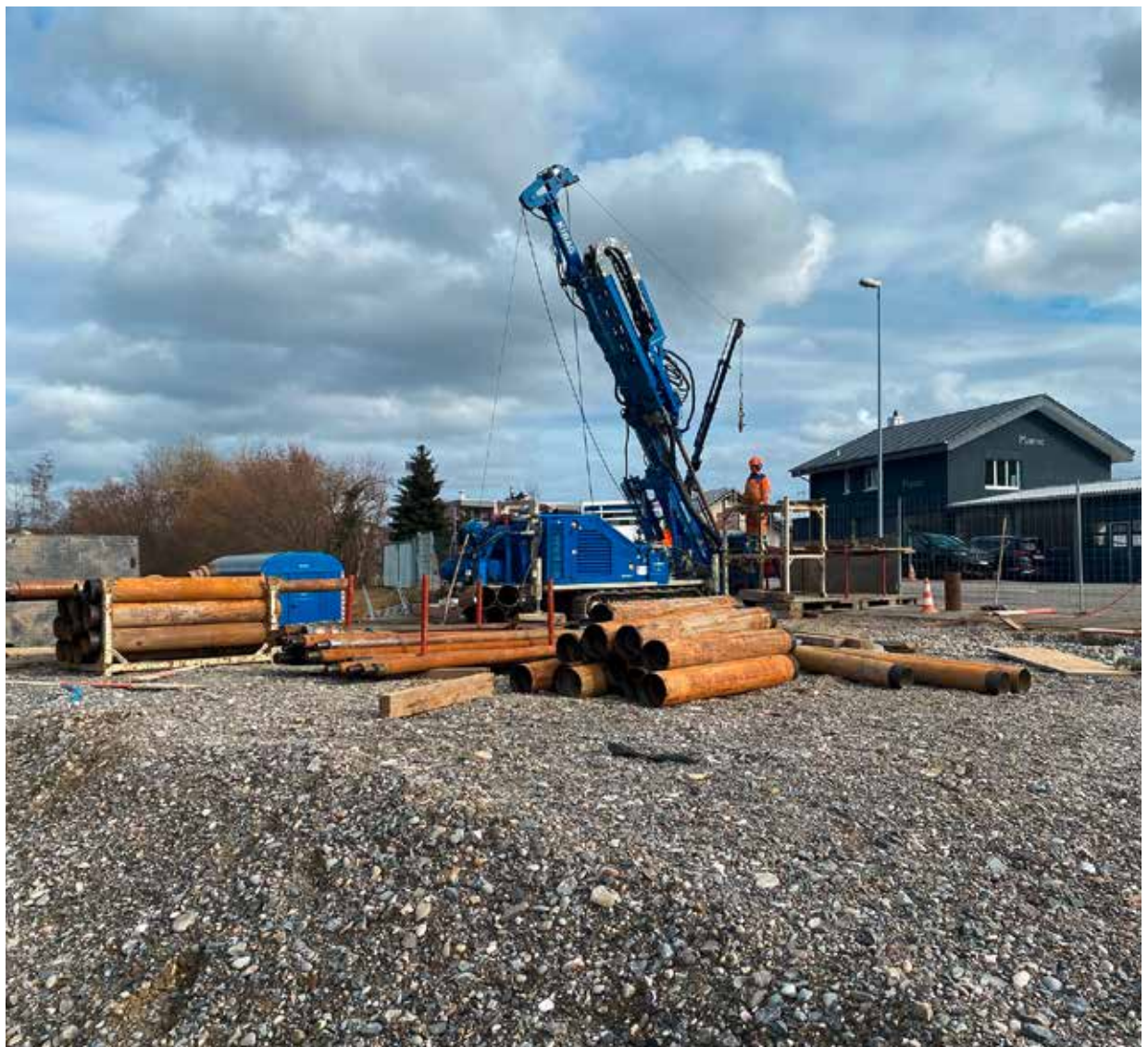
Abb. 5.1: Erstellung der Schrägbohrung KB193 unter der Safenwilerstrasse
