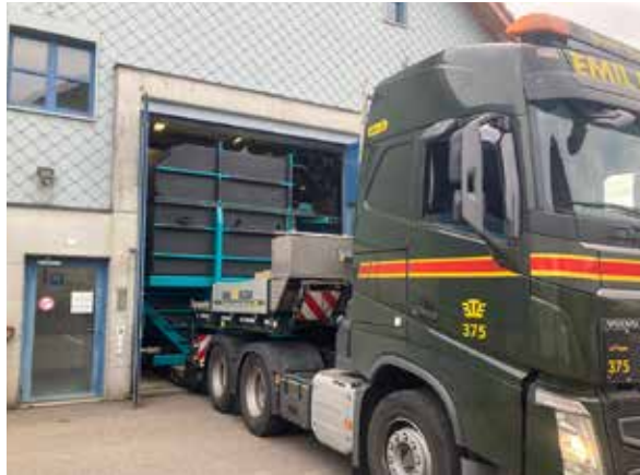
Abb. 3.4: Abtransport des Tauchtropfkörpers mit einem Schwerlasttransport
