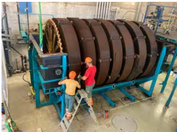
Abb. 3.2: Abbruch Tauchtropfkörper 2
