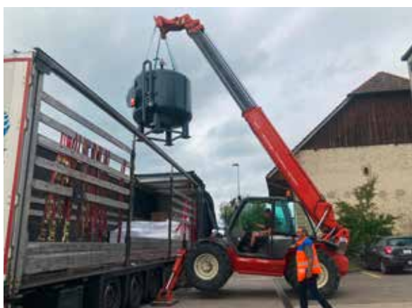
Abb. 3.3: Neuer Aktivkohle-Filter 5 m 3 ; Anlieferung und Ansicht
