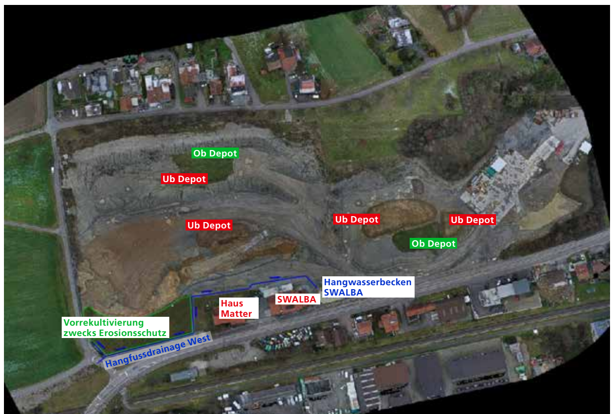
Abb. 5.5: Übersicht Auffüllstelle eSMDK mit verschiedenen Bodendepots
