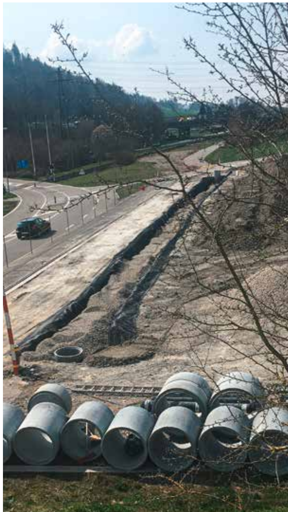
Abb. 5.1: Deponiefussdrainage West im Bau
