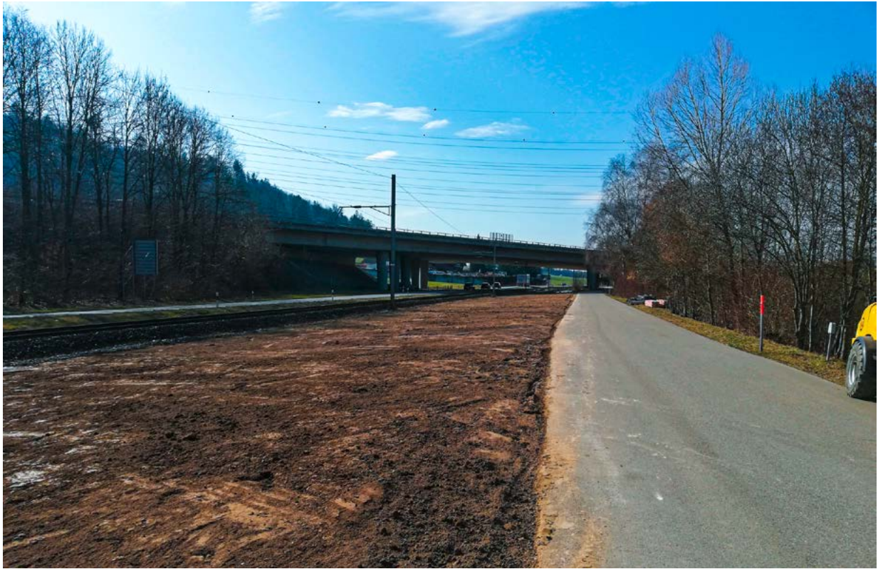
Abb. 5.4: Rekultivierung mit Unter- und Oberboden
