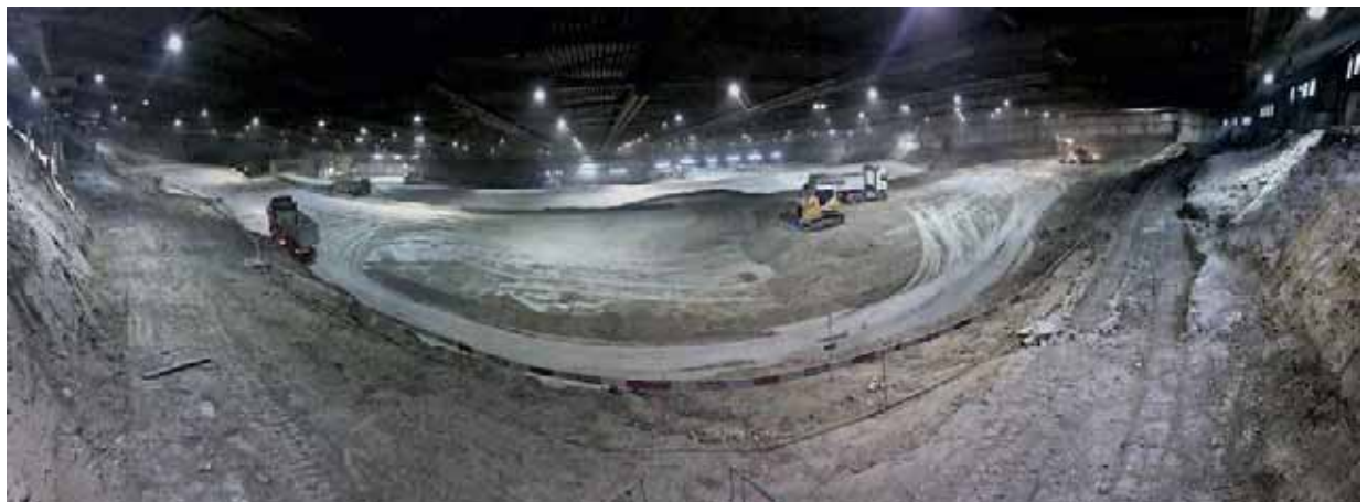
Abb. 5.8: Innenansicht der Abbaubauhalle während der Teilauffüllung
