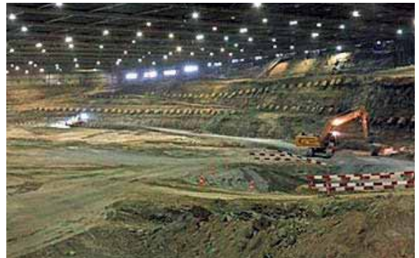
Abb. 5.2: Bau der Sickerleitung an der Nordböschung
