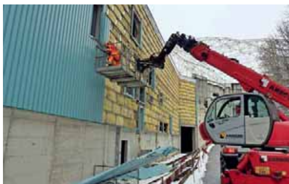
Abb. 5.1: Demontage Fassade Lagerhalle
