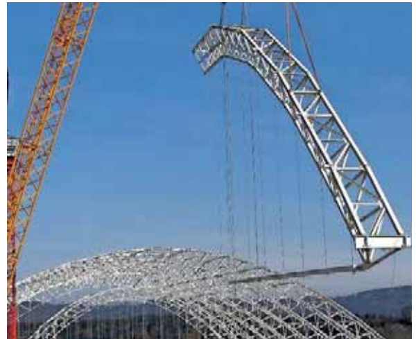
Abb. 5.6: Kran mit angehängtem Bogen während der damaligen Hallenmontage
