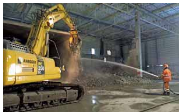
Abb. 5.4: Demontage Lagerboxen Lagerhalle
