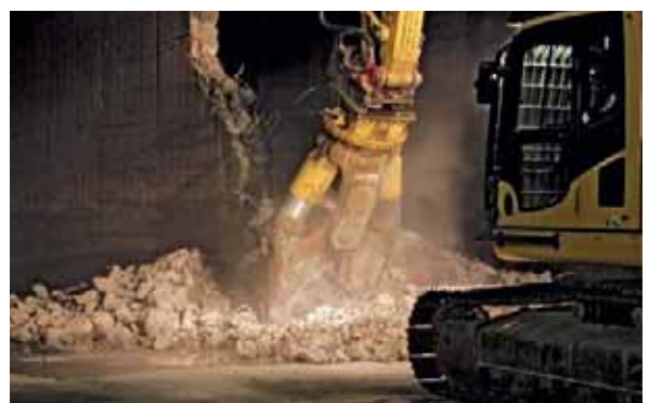
Abb. 5.5: Demontage Lagerboxen Lagerhalle
