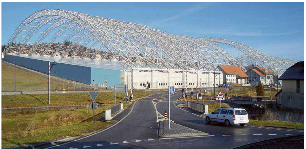
Abb. 5.10: Die grösste freitragende Halle der Schweiz hat ihren Zweck erfüllt.
