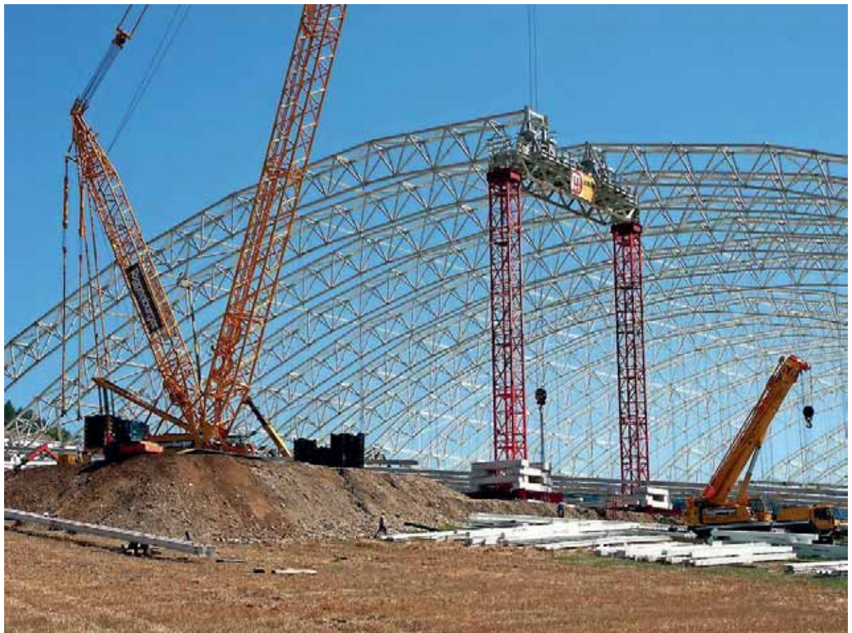
Abb. 5.7: Montage der Bogenhälfte – die Demontage erfolgt in umgekehrter Reihenfolge.
