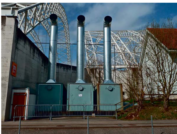
Abb. 5-5: Aktivkohlefilteranlage und Abluftkamine der Ersatzlüftung Los I
