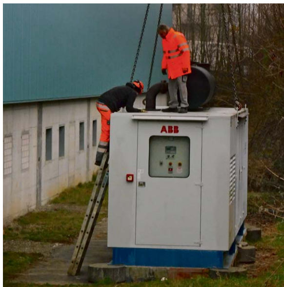
Abb. 3-3: Das Notstromaggregat wird vom alten Standort Lagerhalle zur SWALBA gezügelt.
