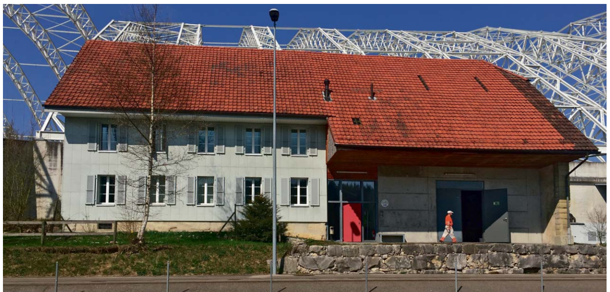
Abb. 2-5: Liegenschaft an der Safenwilerstrasse 34
