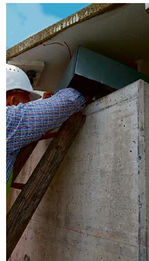
Abb. 5.4: Sichtkontrolle der Lager
