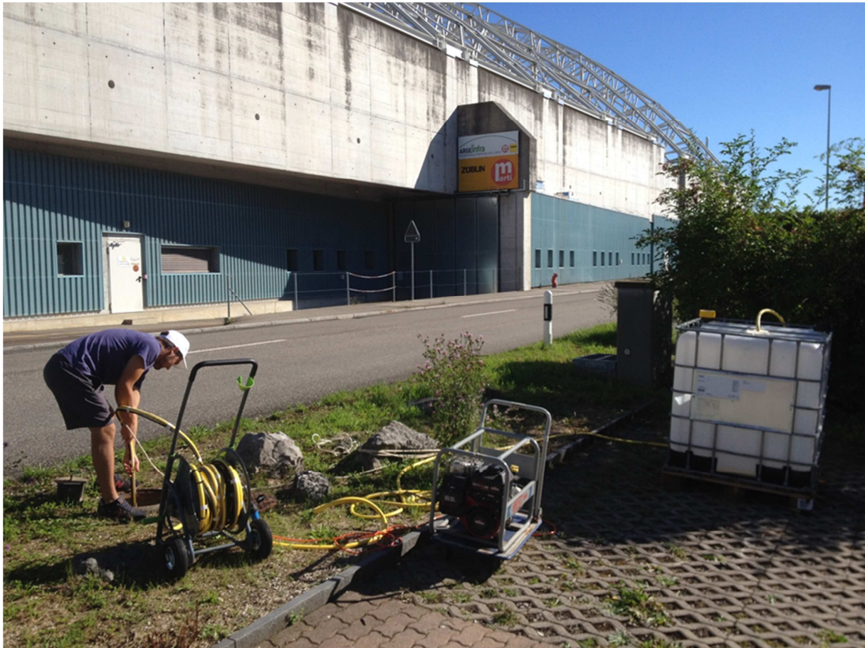
Abb. 8: Bepumpen von KB108B zur Entfernung einer verbleibenden Kontamination im Felsgrundwasser, rechts Generator und Container mit gepumptem Wasser.
