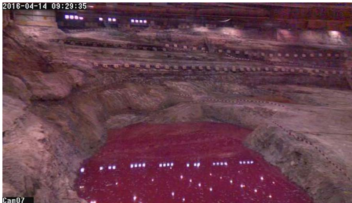
Abb. 10: Aufnahme einer Überwachungskamera des grössten Sees (an der Westflanke), deutlich erkennbar die rote Färbung durch den Markierstoff SRB (Sulforhodamin B), Blick gegen Norden.
