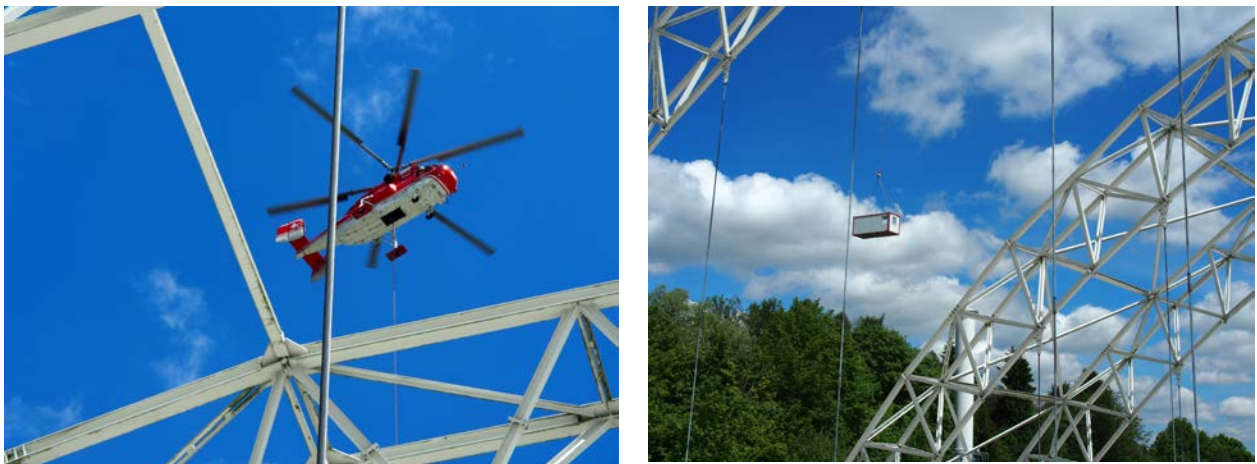
Abb. 1: Abtransport der Bürocontainer der ARGE Phoenix mit dem Kamov Schwerlasthelikopter.
