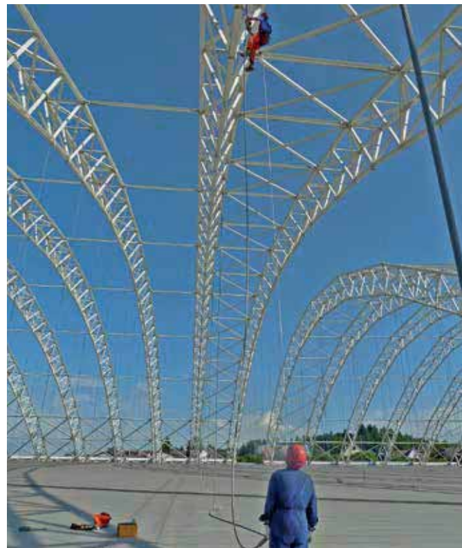
Abb. 5–11: Auswechslung eines Abhängerseils im Bereich der Abbauhalle
