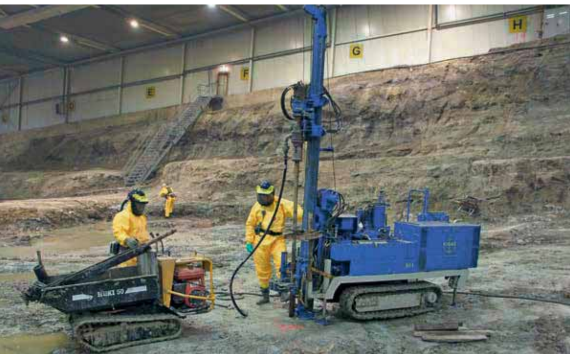
Abb. 5–1: Bohrteam der Kibag AG
