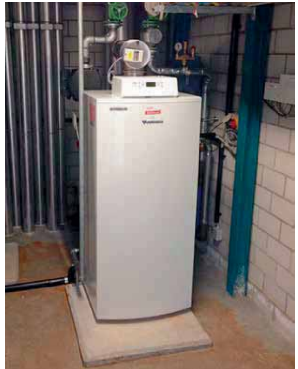
Abb. 3–10: Neue Infrastrukturkomponenten des SWALBA-Gebäudes: Druckluftanlage (links) und Gasheizkessel (rechts)
