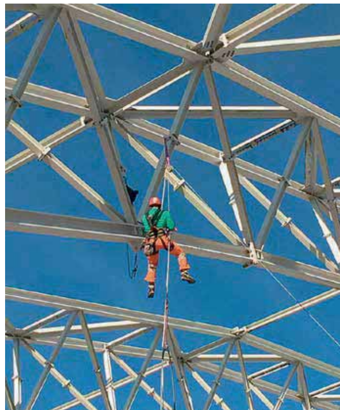
Abb. 5–12: Kontrolle der Abhängeseile an der Dachkonstruktion
