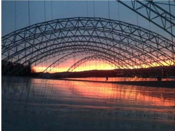
Abb. 11: winterliche Morgenstimmung auf dem Hallendach
