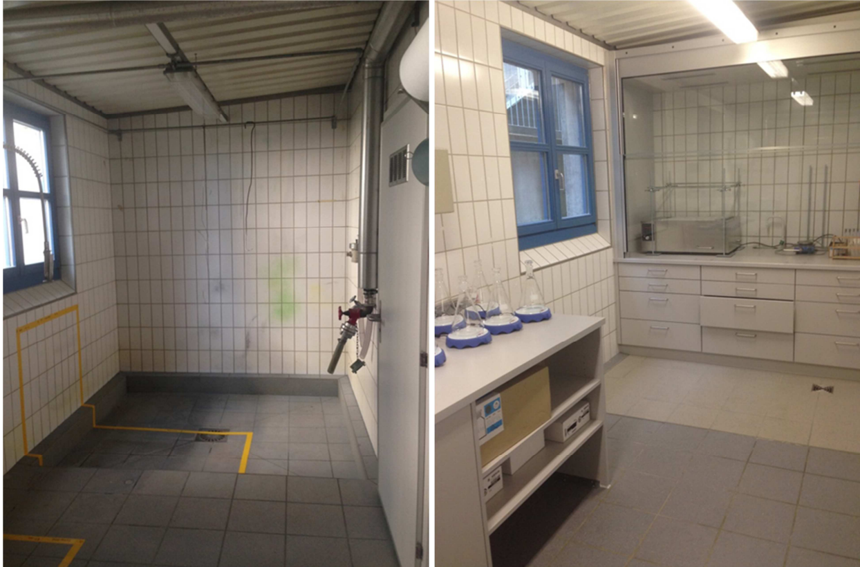
Abb. 14: Waschraum für Filtertücher vor und nach dem Umbau zu einem Probenvorbereitungsraum
