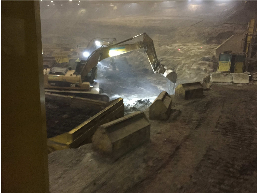
Abb. 1: Ausheben der letzten Schaufel Abfall am 13. Juli 2015
