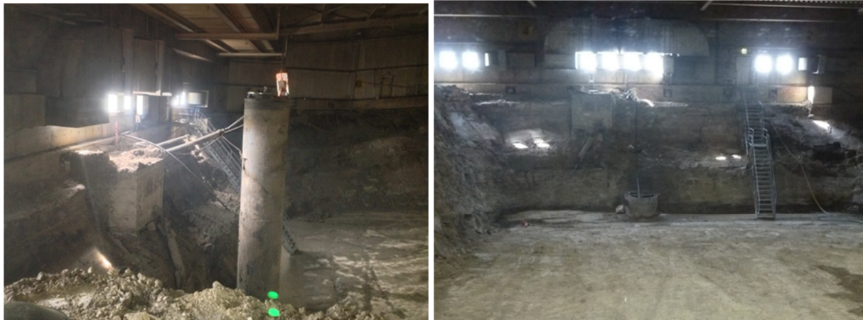
Abb. 12: Zustand Pumpschacht 9 vor und nach den Arbeiten
