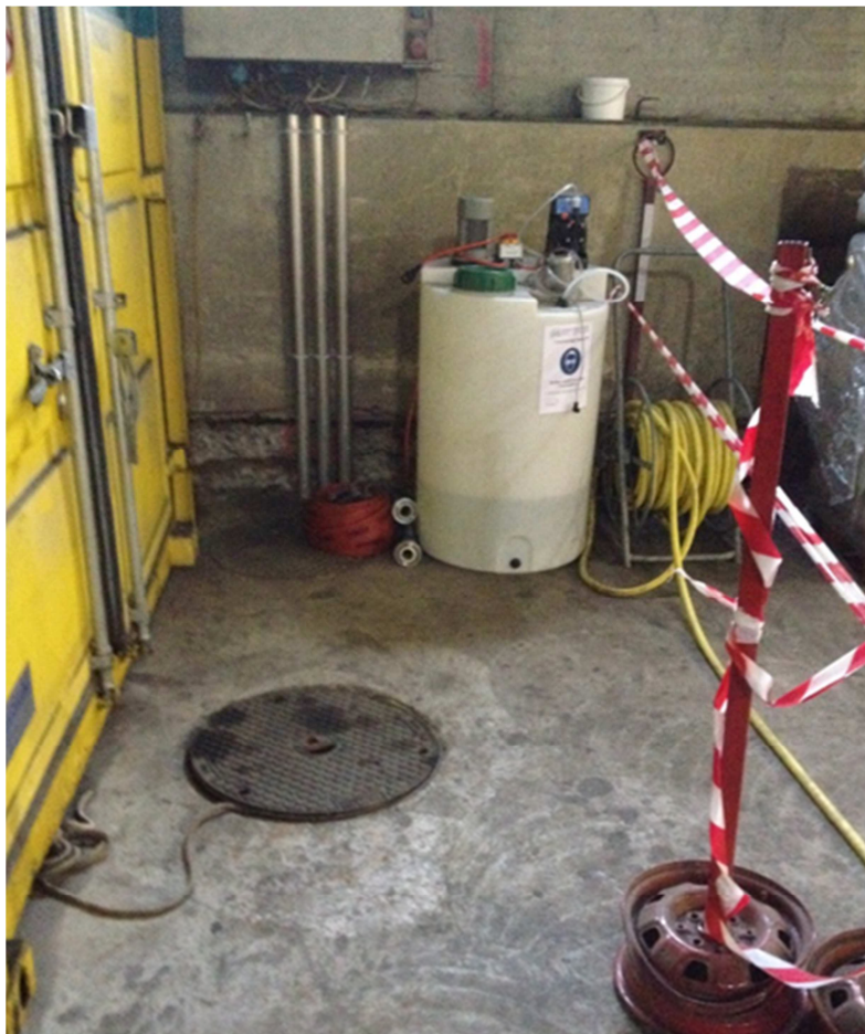
Abb. 6: Deckel des rund 8 m tiefen Schachtes P5 mit dahinter Vorratsbehälter zum Einspeisen der Nitratlösung. Im Hintergrund Südwand der Lagerhalle.
