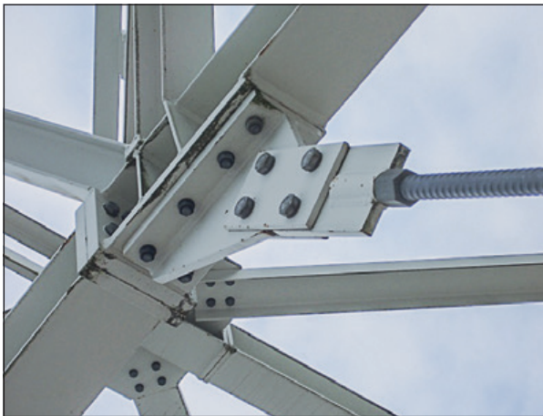
Abb. 5-3: Sichtkontrolle der Fachwerkverbindungen
