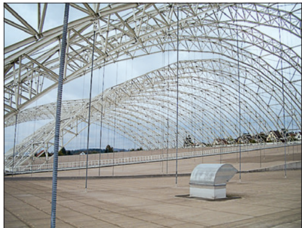
Abb. 5-4: Die Stahlkonstruktion und die Gebäudehülle befinden sich nach wie vor in guten Zustand
