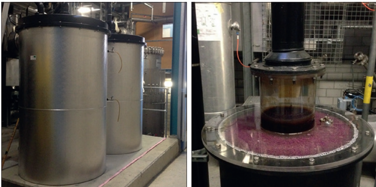
Abb. 3-11: Zwei Aktivkohlefilter für Abluft (links), Schauglas zur Beobachtung der Sättigung des Oxidationsfilters
