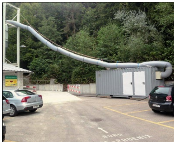
Abb. 4-18: Versuchsanlage für 6'000 m 3 /h auf dem Vorplatz der Lagerhalle.
