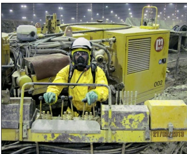
Abb. 5-10: Arbeiter im Schutzanzug am Bohrerät.
