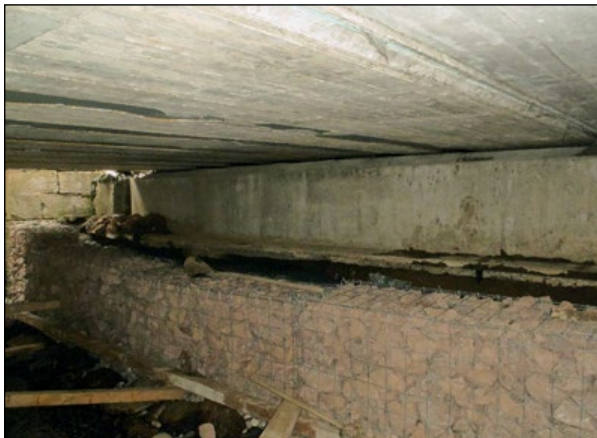
Abb. 5-20: Sanierung mit Steinkörben.
