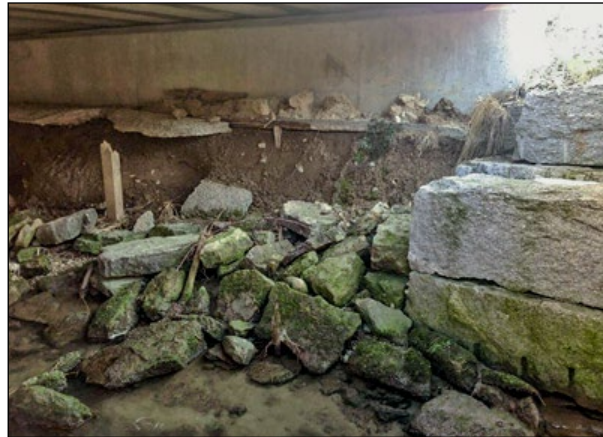
Abb. 5-19: Vorbereitungsarbeiten am Fundament der Mülibach Brücke.
