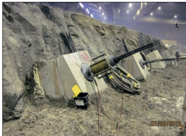
Abb. 5-9: Anker-Spanneinrichtung.
