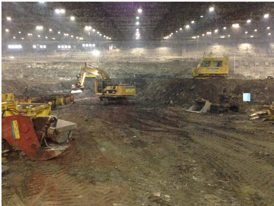
Abb. 1: Der aktuelle Blick mitten in die offene Deponie. Anfang 2011 reichte die Deponie an dieser Stelle noch bis ca. 2m unter das Hallendach.
