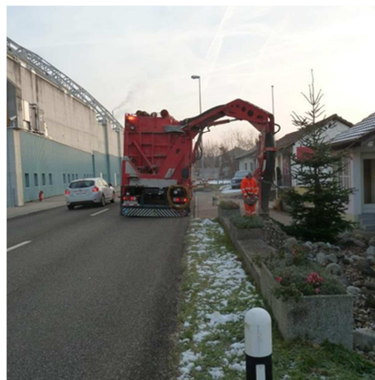
Abb. 14: Erneuerung Hausanschluss Liegenschaft Joller
