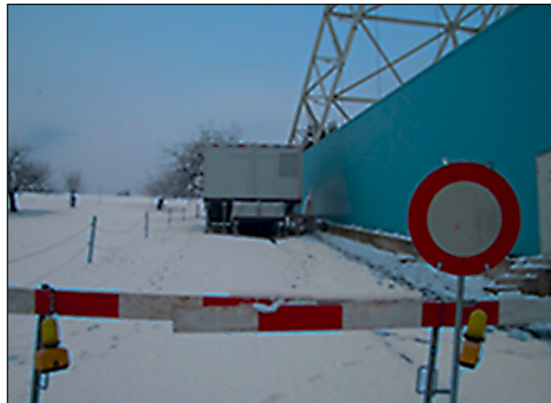
Abb. 5-7: Container der Schwarzweiss-Anlage im Hofgässli an der Westfassade.
