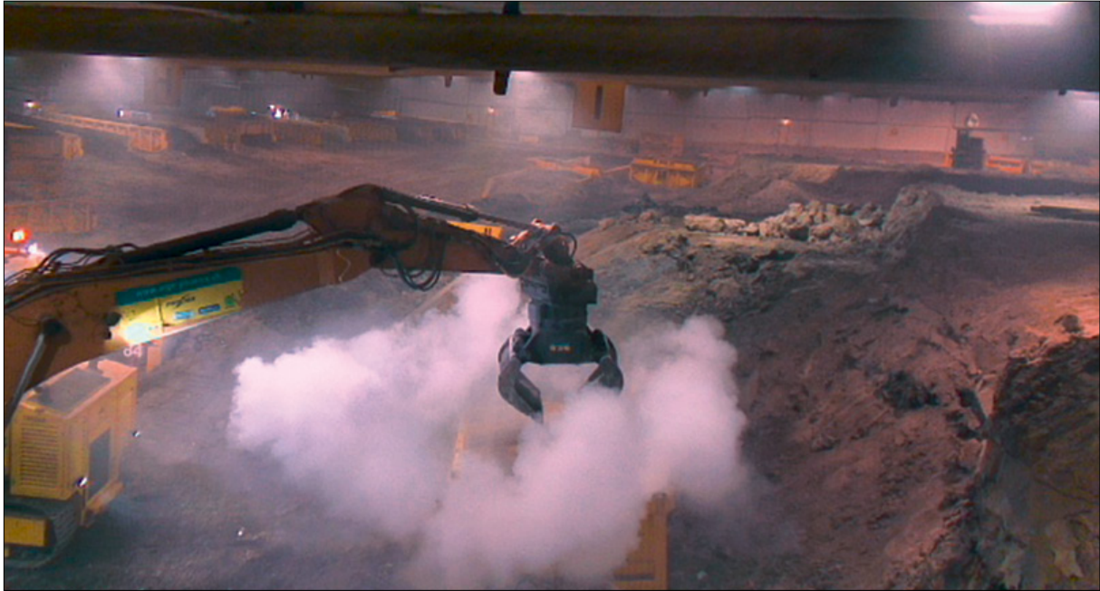
Abb. 5-3: Bild der automatischen Videoaufzeichnung: Rauch durch entzündeten Phosphor in einem Container.
