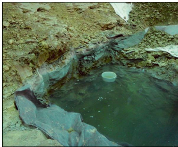
Abb. 4-4: Südende Graben 25 mit Vlies für spätere Geröllfüllung.
