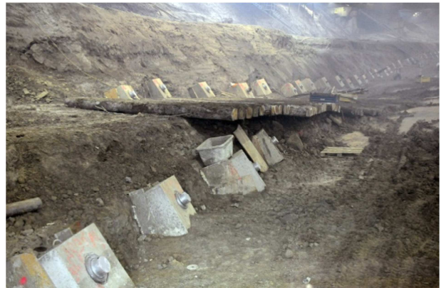
Abb. 4: Ankerköpfe auf den vorfabrizierten Ankerplatten, Positionen an der Gesteinsfestigkeit angepasst
