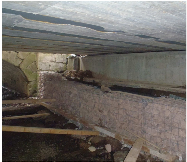
Abb. 6: Sanierung mit Steinkörben
