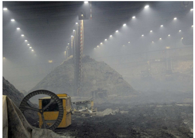
Abb. 2: Schutzwall mit Netz darüber gegen Splitterwurf
