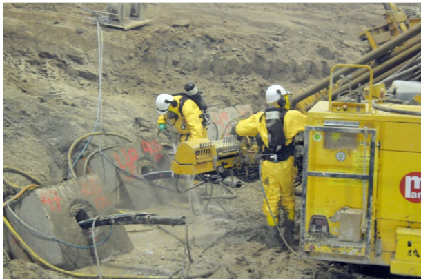
Abb. 3: Ankerarbeiten mit Vollschutzausrüstung
