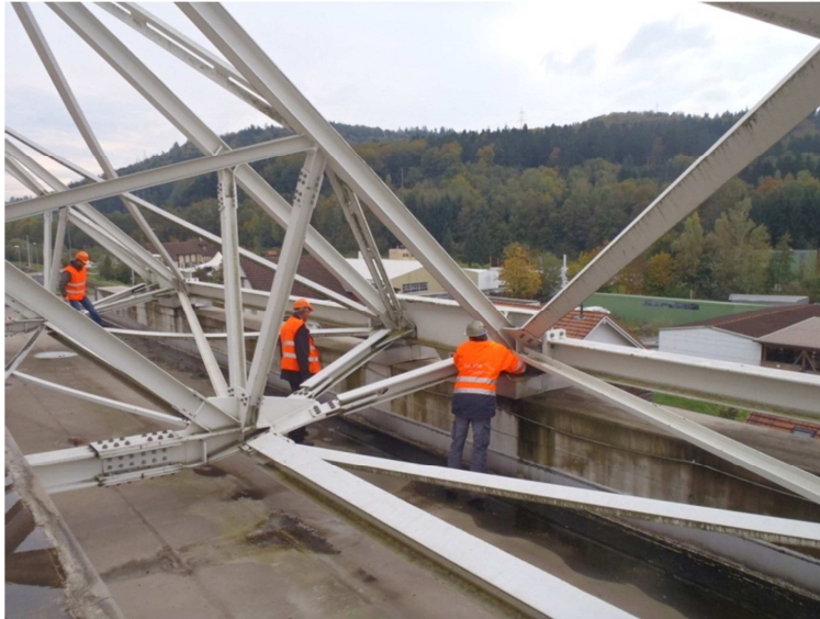
Abb. 1: Kontrolle Stahlkonstruktion und Auflager am 15.10.2012.
