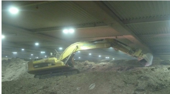
Rückbau knapp unter dem Hallendach
