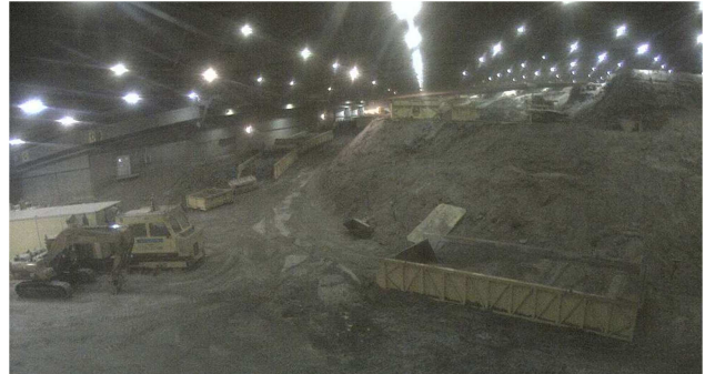
Webcambild Abbauhalle 1.10.2011, Blick gegen SW, links Dockingstation; Rückbau oberhalb östlicher Böschung
