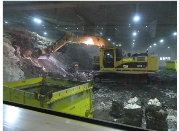
Rückbau von weisslichem asbesthaltigen Material in Fässern
