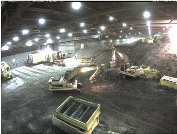
Rückbau mit 2 Bagger, im Vordergrund Beprobungs-Handlingscontainer (Bild der Webcam)
