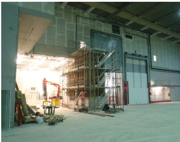
Neubau Probenahmekanzel durch das Los I
