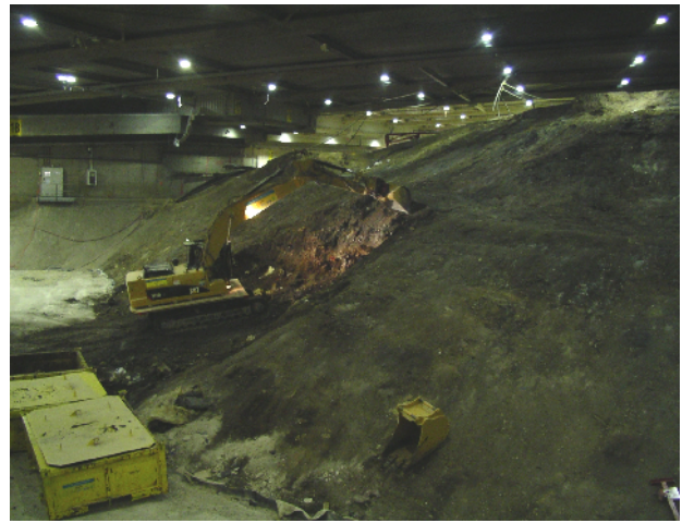
RE2: Deponierückbau vor der Dockingstation West ab 29.03.2011
