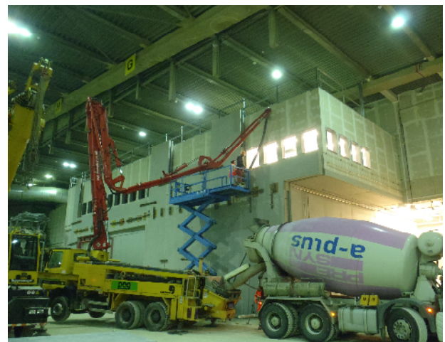
Betonieren Elementwand, Bereich Leitwarte und Besucherraum (Los I)
