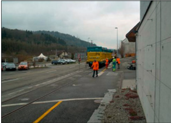
Abb. 5-22: Überprüfung Eisenbahnbetrieb vor Aufnahme der Abtransporte
