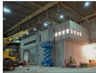
Abb. 5-4: Montage Explosionsschutzwand
