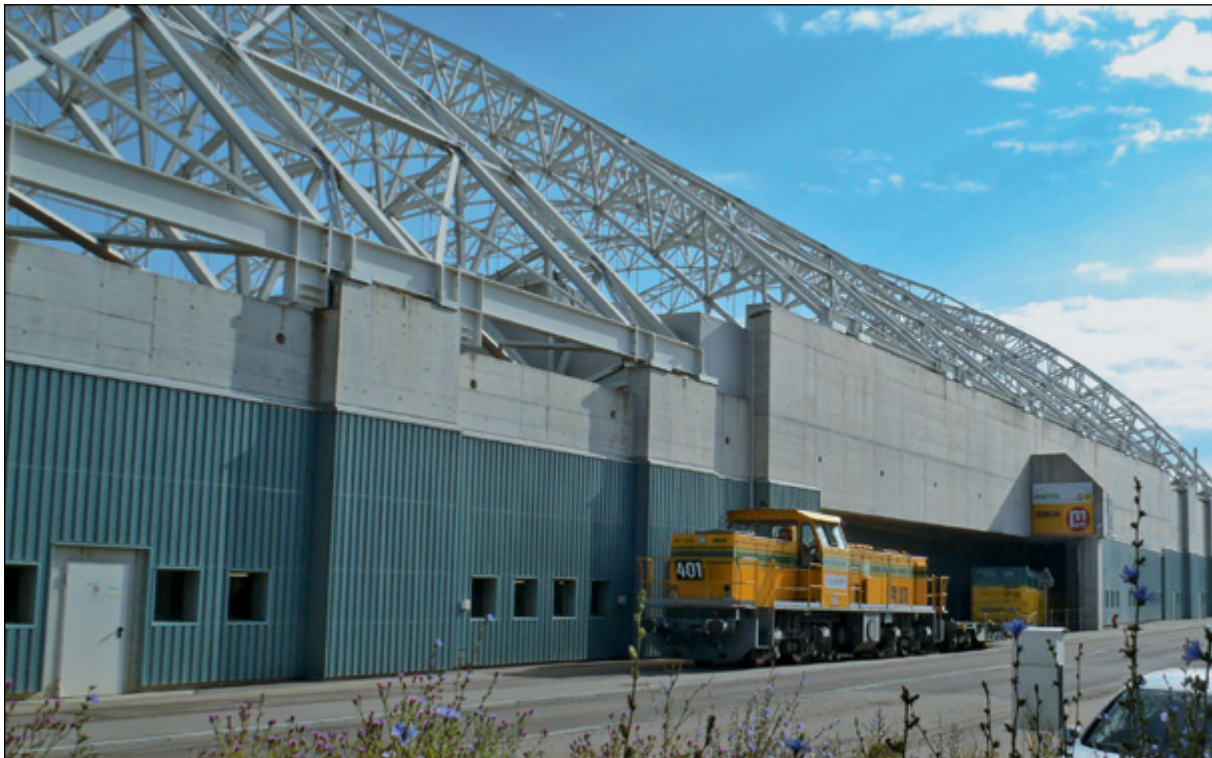
Abb. 4-7: Bahneinfahrt in die Halle an der Safenwilerstrasse
