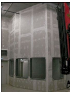
Abb. 5-5: Kanzel mit Gipskarton- wänden vor Umbau
