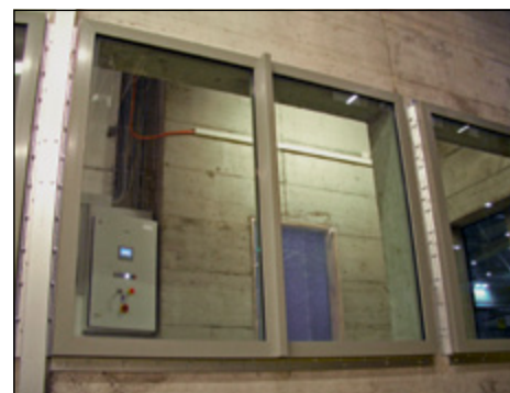
Abb. 5-7: Geschützte Probenahmekanzel aus Beton mit explosions sicheren Fenster
