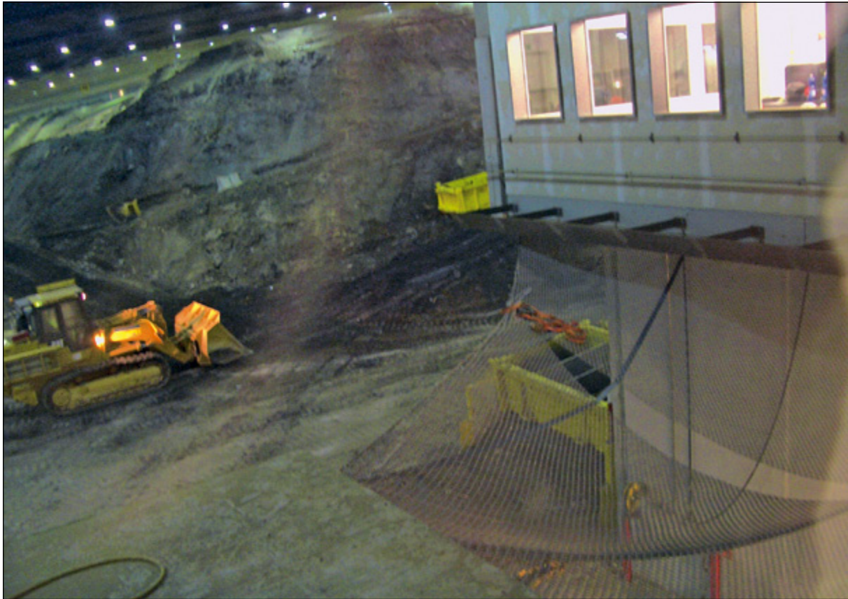
Abb. 5-8: Sicherheitsnetze schützen gegen Trümmerwurf
