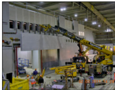
Abb. 5-3: Errichtung der vorgesetzten Betonwand
