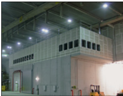
Abb. 5-2: Besucherraum und Leitwarte vor Umbau
