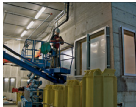
Abb. 5-6: Montage der Fenster
