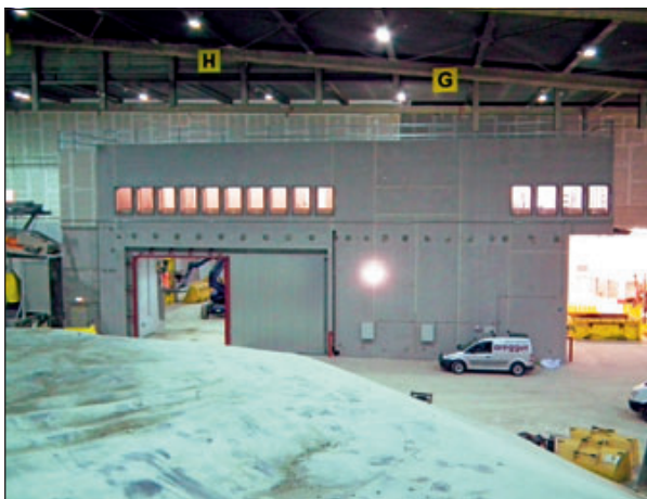
Abb. 2-1: Blick von Deponie auf Besucherraum (Fenster oben links), Fenster rechts: Leitwarte
