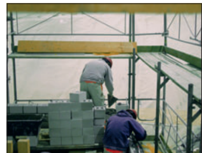
Abb. 5-5: Treppenhäuser wurden konventionell gemauert
