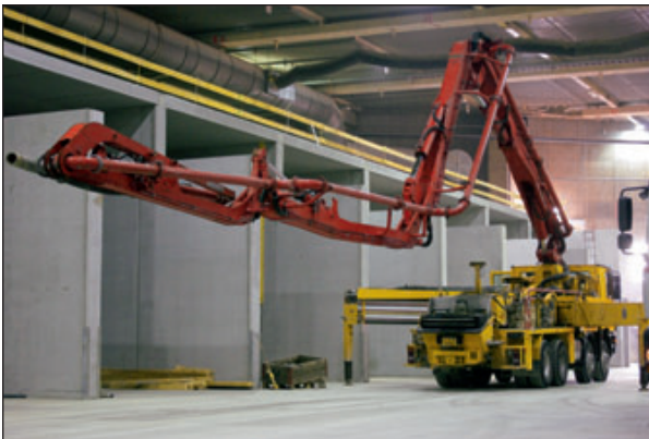
Abb. 5-1: Einsatzbereite Betonpumpe
