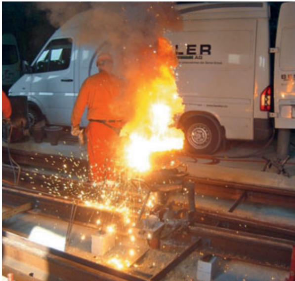
Abb. 5-20: Gleise verschweißen
