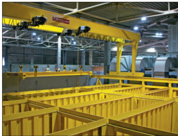
Abb. 5-19: Aktivkohleanlage der Abluftbehandlung
