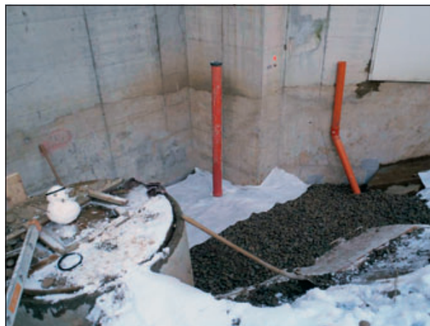
Abb. 5-17: Neue Drainagen (kiesbedeckt) an der nördlichen Aussenwand der Lagerhalle
