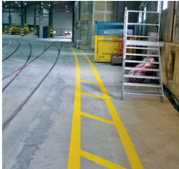
Abb. 5-21: Dienstweg an Gleisanlage
