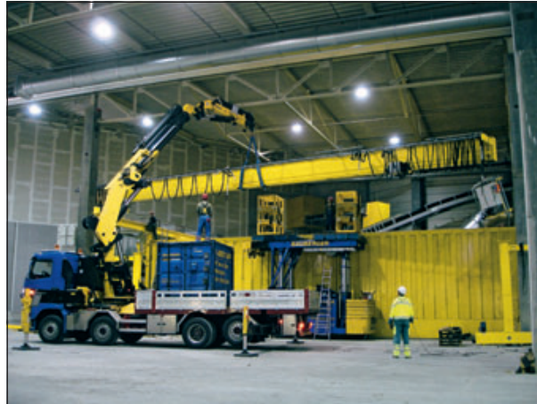
Abb. 5-9: Montage Portalkran, Aktivkohlebehälter (hinten)
