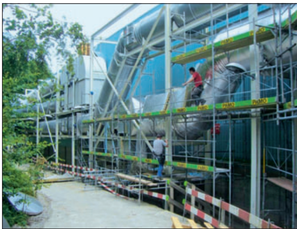
Abb. 5-18: Montage der Lüftungsleitungen nördlich der Manipulationshalle
