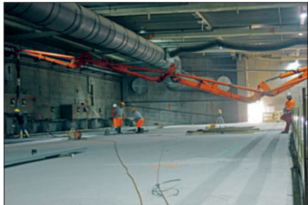
Abb. 5-2: Betonieren der Decken
