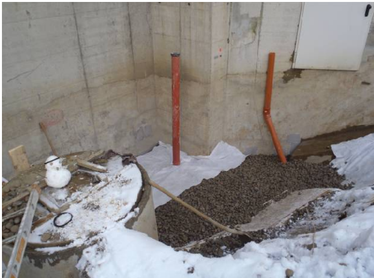
Ersetzte Drainage (kiesbedeckt) auf der Nordseite des Bereichs Manipulationshalle/Lagerhalle.
