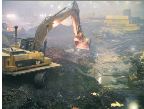
Abb. 5-2: Rückbau im Bereich der Deponiesohle, aus der Hangwasser austritt
