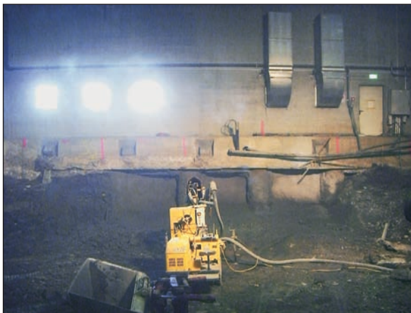
Abb. 5-16: Pfahlausfachung an der Safenwilerstrasse im Zug des Deponieaushubs (08.07.2009)
