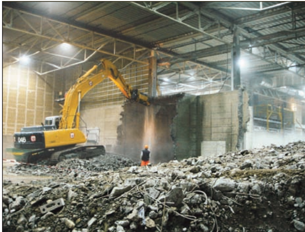
Abb. 5-5: Demontage und Abbruch der Infrastruktur im Bereich der Trennwand Schwarz-/ Weissbereich
