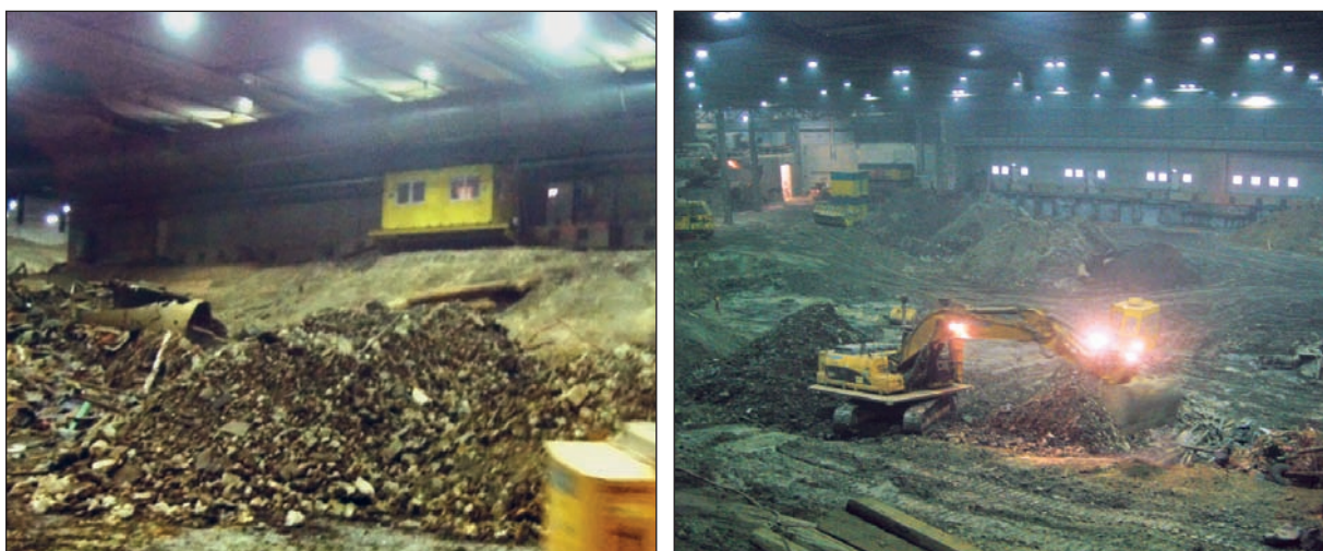
Abb. 2-2: Beobachtungcontainer (Bild links) und Blick aus dem Beobachtungscontainer in den Rückbaubereich (Bild rechts)
