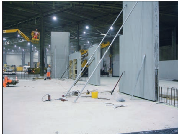
Abb. 5-8: Stellen der ersten Wandelemente mittels vorfabrizierten Hohlwänden
