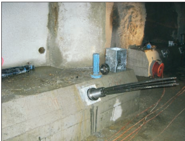
Abb. 5-18: Spannen der Anker auf der Nordseite der Manipulationshalle (10.12.2009)
