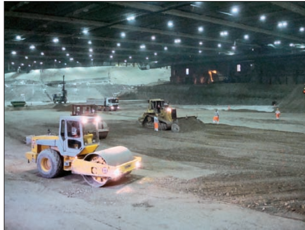
Abb. 5-6: Aufschüttung und Erstellung des Planums für die neue Bodenplatte
