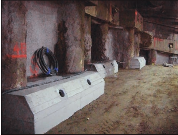
Abb. 5-17: Longarinen für die zweite Ankerlage auf der Nordseite der Manipulationshalle (16.11.2009)
