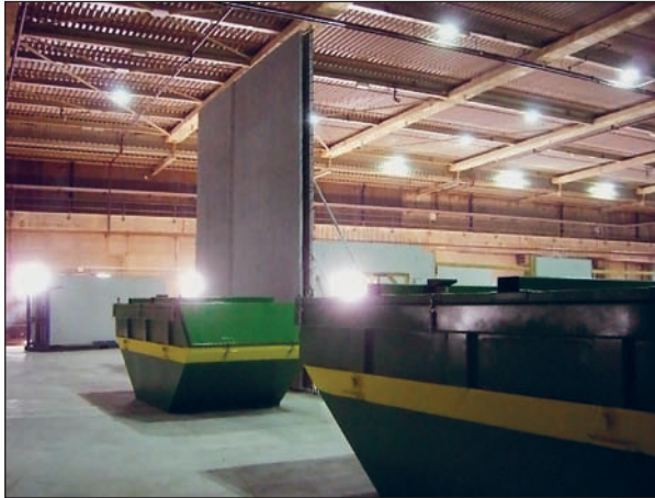
Abb. 5-15: Stellen der ersten vofabrizierten Wände (22.12.2009)
