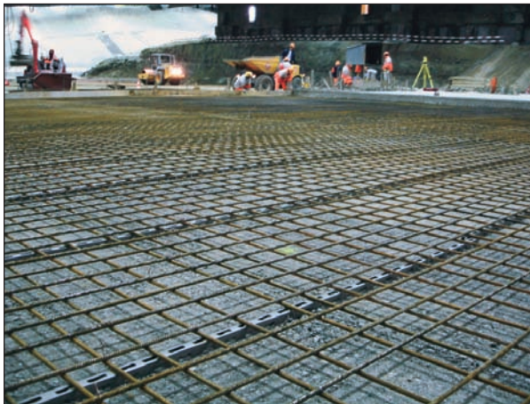
Abb. 5-7: Schalung, Bewehrung und Betonieren der Bodenplatte
