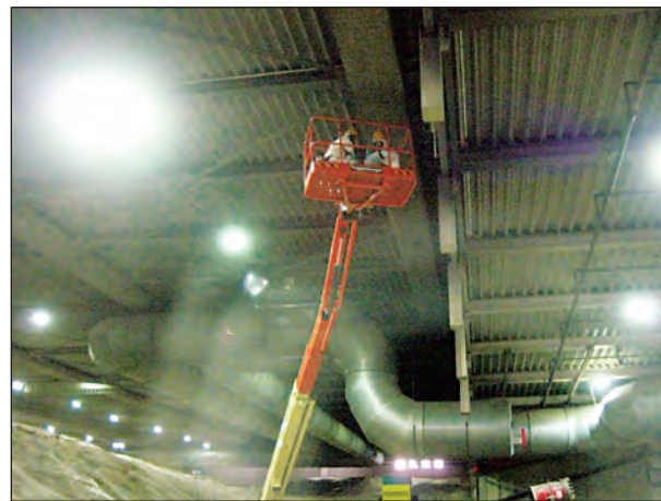
Abb. 5-7: Reparaturarbeiten im Schwarzbereich
