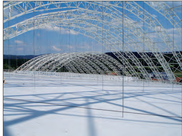
Abb. 5-14: Kontrolle Dichtigkeit Gebäudehülle
