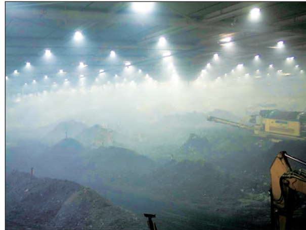
Abb. 5-24 Rückbaubereich am 23.06.2008 um 17.23 Uhr
