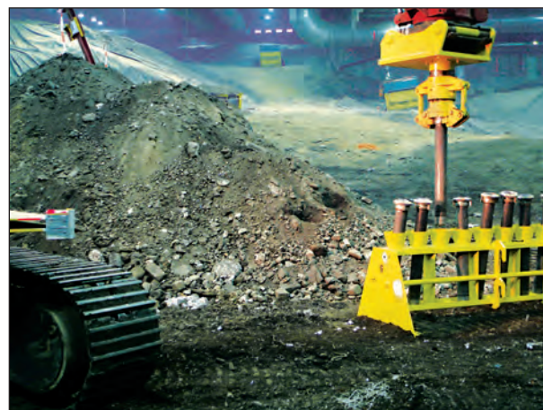
Abb. 5-28: Transportgestell für die Stahlrohre
