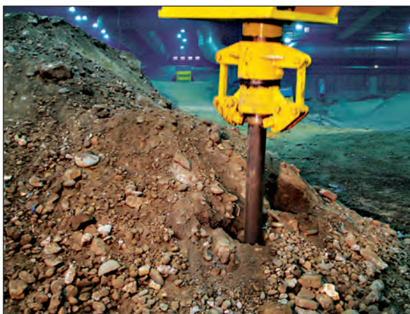
Abb. 5-27: Mechanische Probenahme vom Bagger aus mit Stahlrohren
