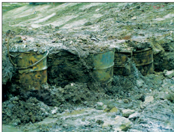
Abb. 5-17: Rückbaufront: freigelegte Fässer
