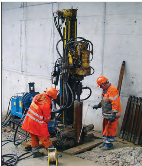
Abb. 4-1: Abteufen der Inklinometerbohrung KB172 nahe der östlichen Wand der Manipulationshalle
