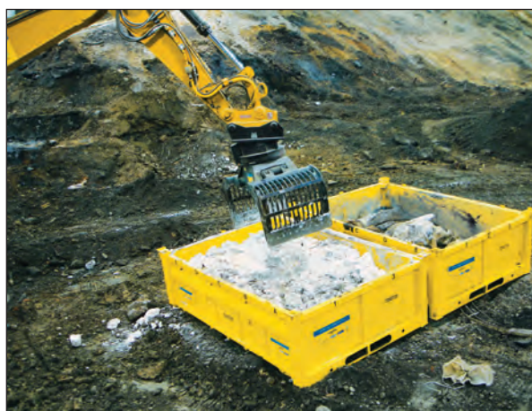
Abb. 5-20: Rückgebautes Material aus Big Bags
