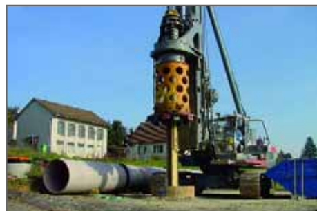
Abteufen der Filterbrunnen
