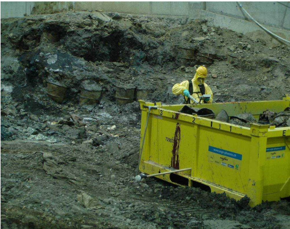
Probnahme des rückgebauten Materials
