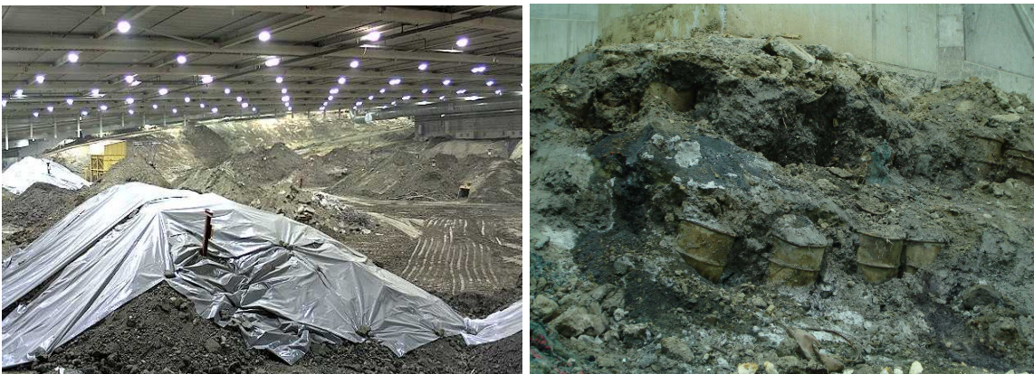
Deponierückbau in der Manipulationshalle, freigelegte Fässer
