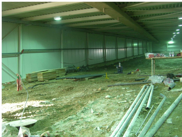
Letzte Arbeiten in der Abbauhalle
