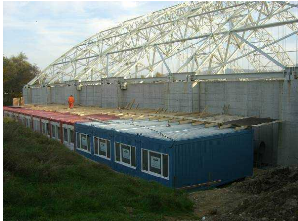
Containerdorf nördlich der Manipulationshalle
