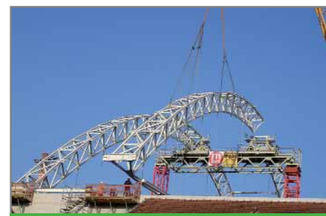
Eine Bogenhälfte wird versetzt
