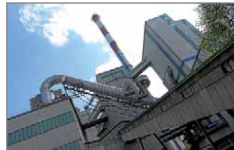
Ausglühen im Zementofen
