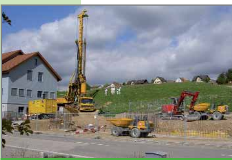
Bohrarbeiten für den Pfahlkopfriegel
