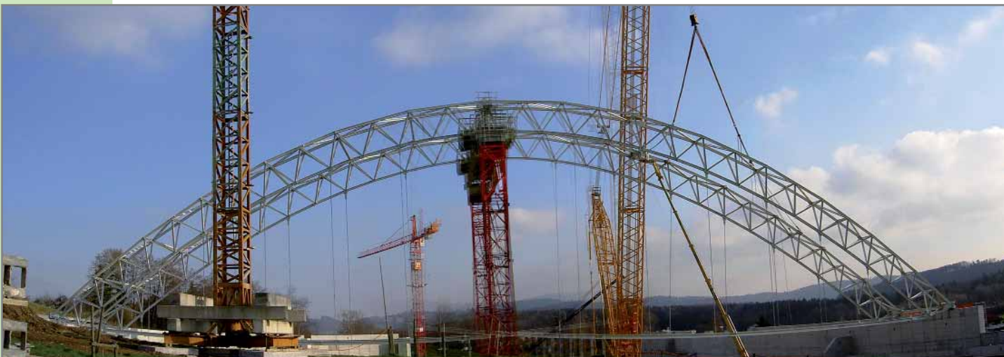
An den Bogentragwerken hängen später die Hallendächer
