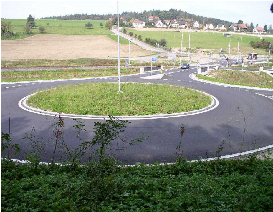
Neuer Kreis bei der Einmündung der Safenwilerstrasse in die Holzikerstrasse
