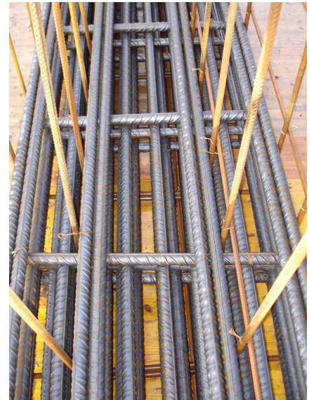
Armierung des Querträgers über der Eisenbahneinfahrt: die Stahlarmierungen sind bis zu 32 mm stark.
