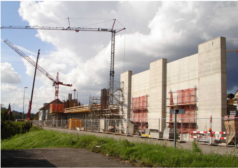
Pfeiler und Wände auf der Südseite der Manipulationshalle
