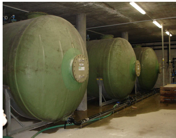
Umplatzierte Speichertanks (3 x 70 m 3 )
