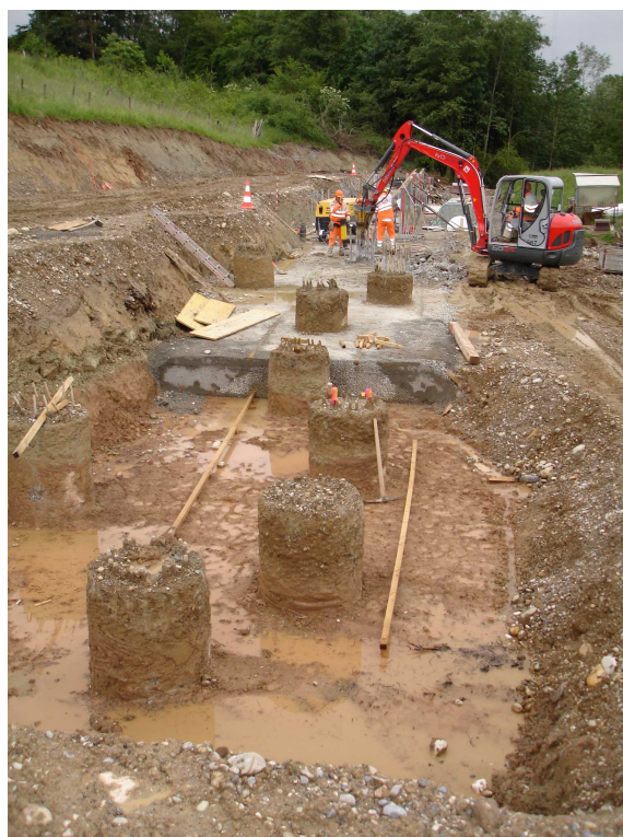
Vorbereitung des Pfahlkopfriegels Etappe 2
