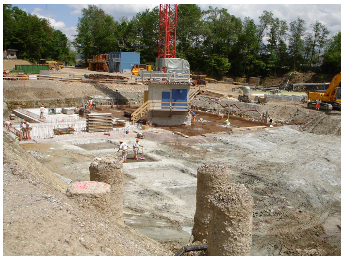
Bau der Bodenplatte des Wasserkellers (Lagerhalle)
